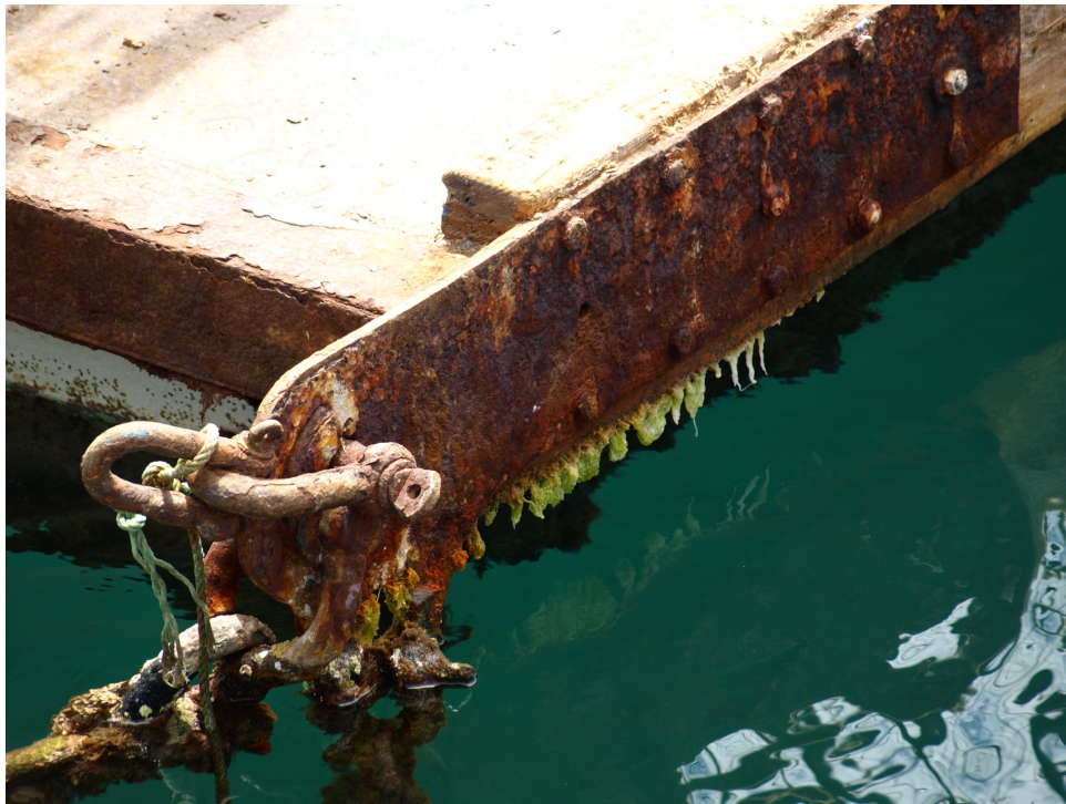
Fig. 1. Diversos ejemplos de biofouling en el puerto de Taliarte, Gran Canaria.
